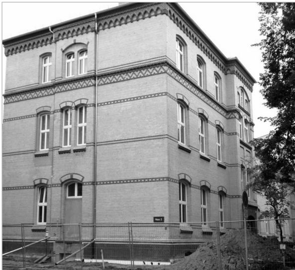
Abbildung 3: Interimsmäßige Unterbringung der Psychosomatischen Station 1998-2001 im Haus 2, 1. Obergeschoß, vor der Sanierung des Gebäudes
