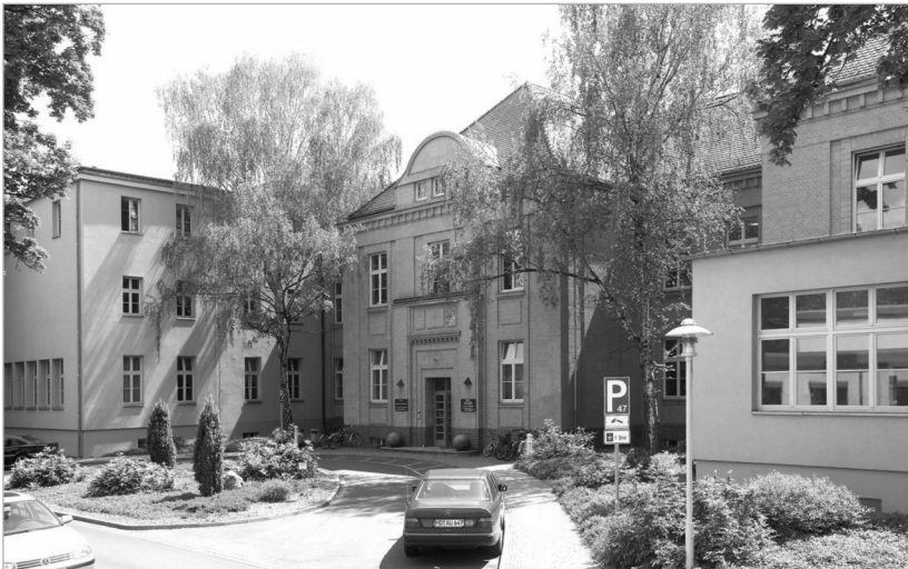
Abbildung 5: Unterbringung der Psychosomatischen Station 2005-2013 im Haus 4, 2. Obergeschoss, nach der Sanierung des Gebäudes
