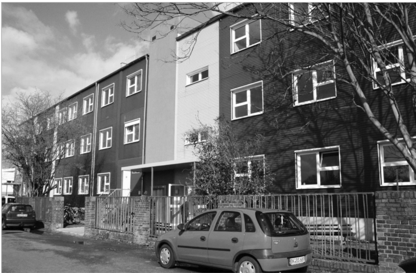
Abbildung 4: Interimsmäßige Unterbringung der Psychosomatischen Station 2001-2005 im Container-Anbau der Kinderklinik an der Wiener Straße, Hochparterre
