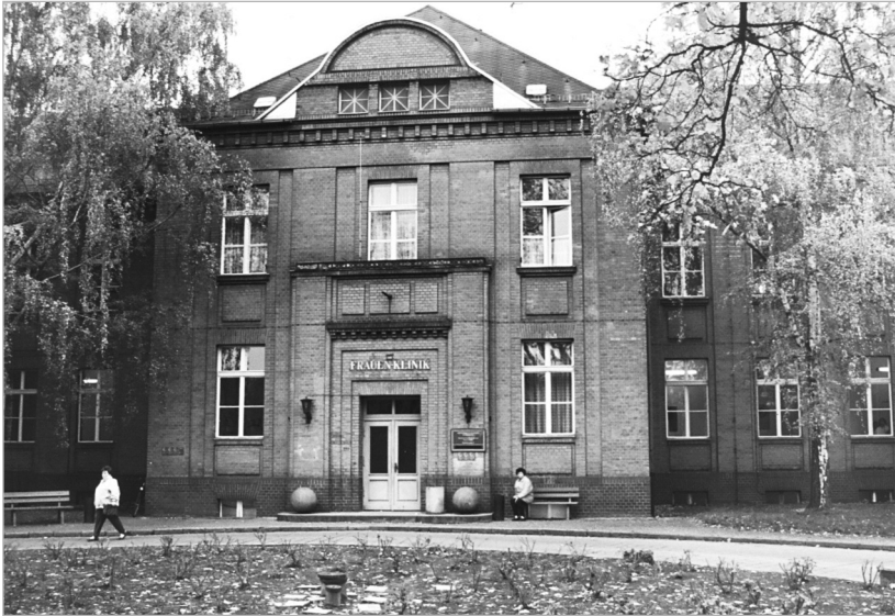
Abbildung 2: Interimsmäßige Unterbringung der Psychosomatischen Station 1996-1997 im Haus 4, Erdgeschoß, vor der Sanierung des Gebäudes
